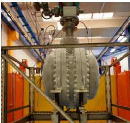
Purge de craquage à la vapeur (torche sans fumée au niveau du sol), Italie
