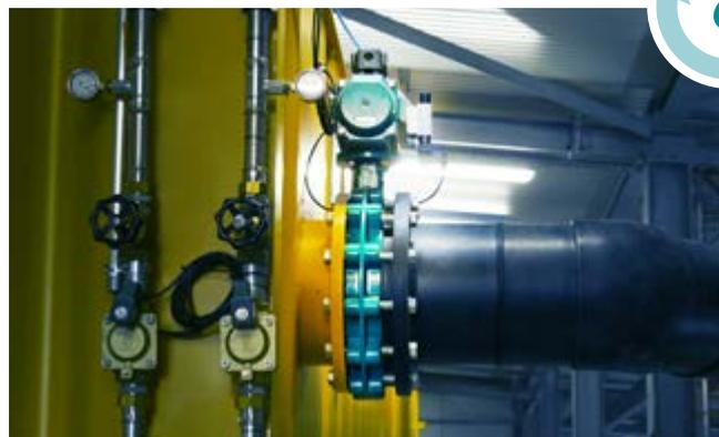
d'autres applications de traitement de l'eau, elle utilise des robinets à papillon Desponia avec corps en fonte ductile revêtu de Rilsan, manchette EPDM et actionneurs manuels ou pneumatiques. La maintenance simple et des temps de réaction courts contribuent à la fiabilité de l'extraction du gravier et au traitement irréprochable dans la gravière.
