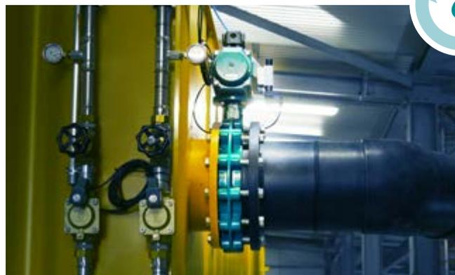
impiegate, ad esempio, per trattare le acque dense di detriti. Le valvole a farfalla Desponia, con il loro corpo in ghisa sferoidale, il disco in ghisa sferoidale rivestito in Rilsan, la guarnizione EPDM e gli attuatori manuali o pneumatici, sono invece utilizzate per altre applicazioni di trattamento acque. Inoltre, la facile manutenzione e i celeri tempi di risposta contribuiscono a garantire un'estrazione della ghiaia affidabile e un'ottima operatività nello stabilimento.
